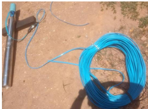
Bomba empalmada con el cable de potencia
