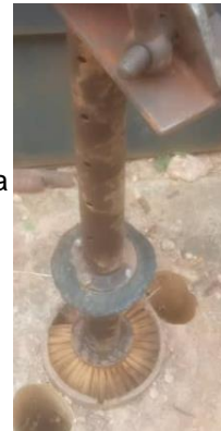
Instalación de baqueta y jetter
