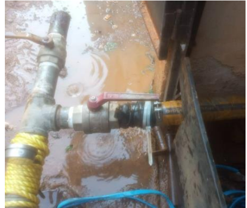
Instalación temporal para suministrar agua al tanque
